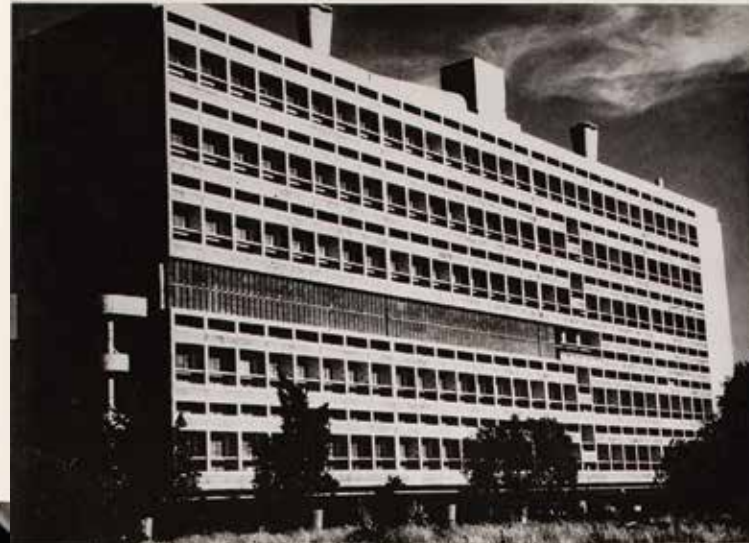
Le Carthusier - Kollektivna stanbena zgrada u Marcellu 1940-51
